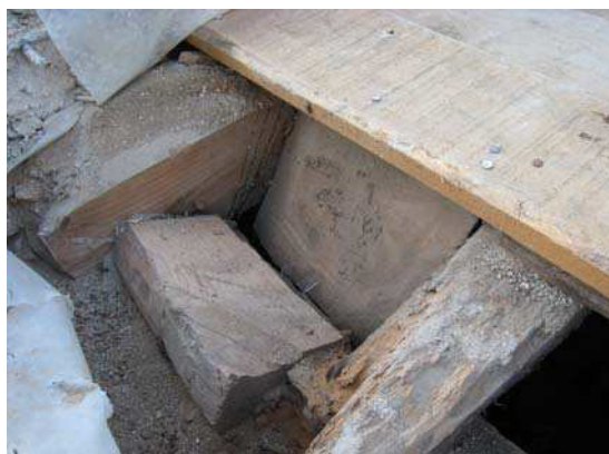
Tapa entre correas y nuevo tablero
