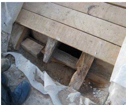
Apoyo correas en muro sobre durmiente
