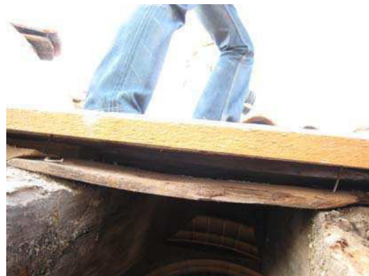
Entablado original + nuevo tablero
