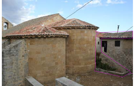
Casa del santero. Estructura en ruina. No se actuará en esta fase de obra.
