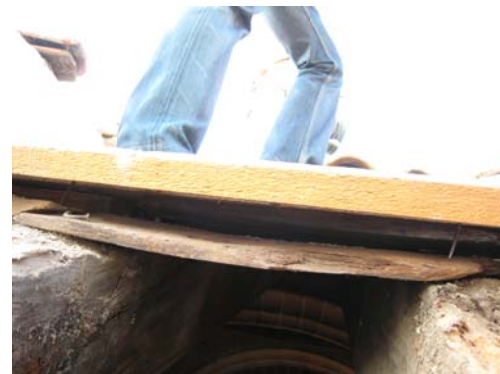
Faldón Sur. Estado actual
