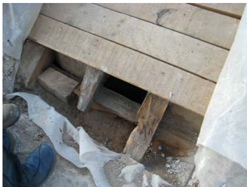
Faldón Sur. Estado actual
