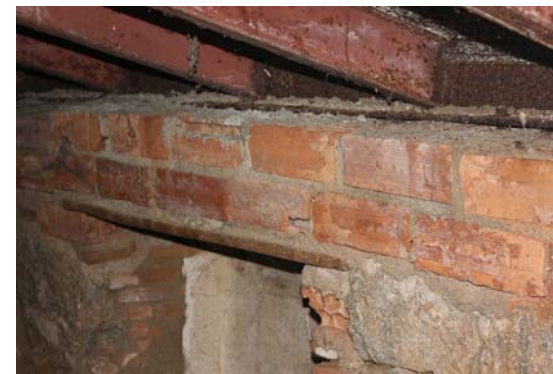
Faldón Norte Convento. Estado actual
