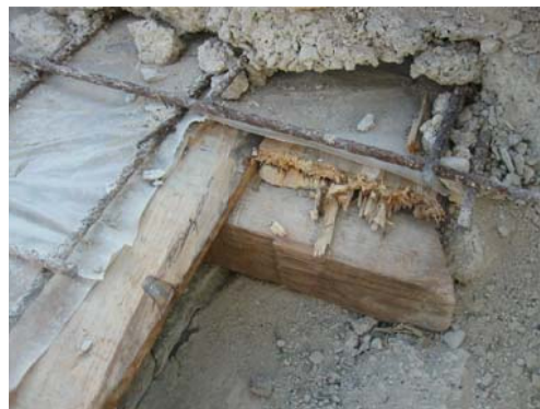
Faldón Norte Iglesia. Estado actual
