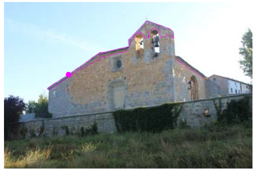
Fachada Oeste y Sur. Tratamiento de bordes de cubierta. Demolición y sustitución de mampostería o recolocación.
